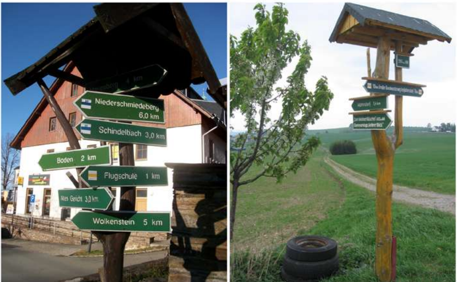
Wegweiser an Zwiesel mit Schutzdach angebracht, rechts mit U-Profil
